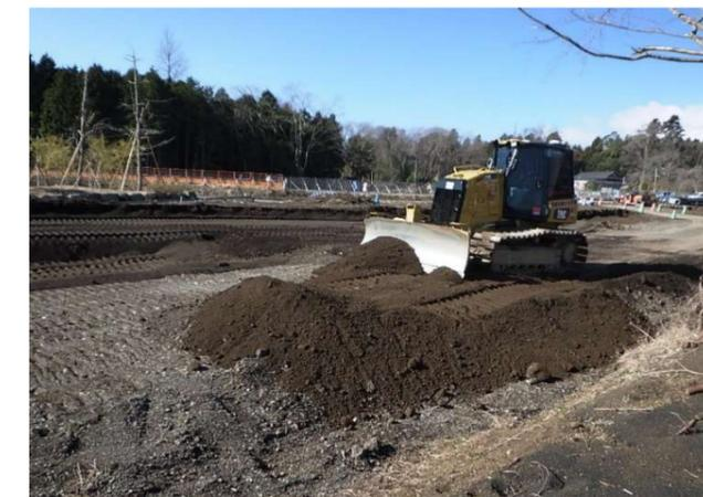
ICTブルドーザーによる盛土作業
